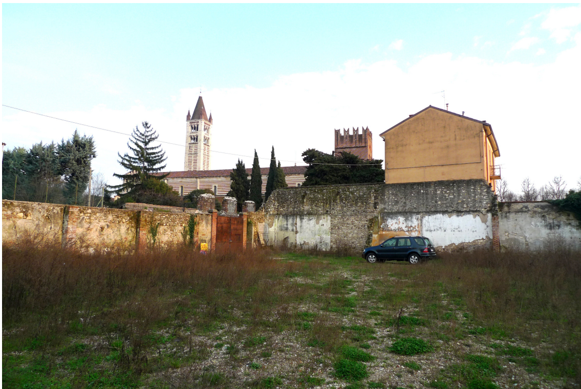
vista dell'area a sud
